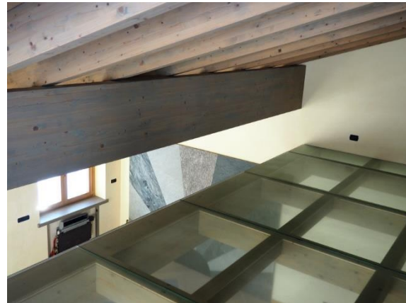
La sala al livello 2 sottotetto, ricavata per mezzo di soppalco con pavimento in vetro e legno
