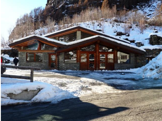
Il fronte nord del fabbricato da destinare a sede del Museo diffuso del Serpentino per la parte coperta, presso località Pinchino
