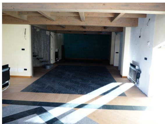
La sala al livello 1. In tutto il fabbricato sono già installati i fan-coil che necessitano solamente delle griglie di copertura
