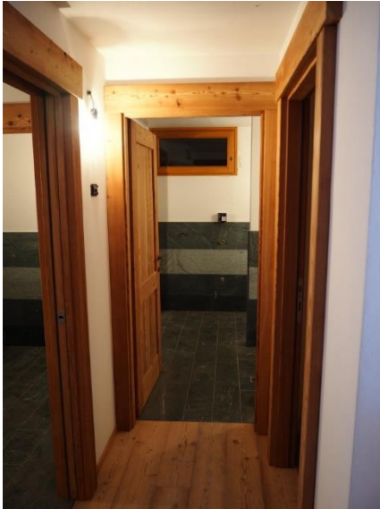
Il locali dei servizi igienici sono nuovi e mancano solo dei sanitari e di alcune finiture. Si trovano al livello 1 ribassato
