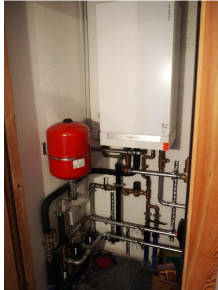
Le predisposizioni impiantistiche per la produzione di acs e del fluido vettore per il riscaldamento sono complete
