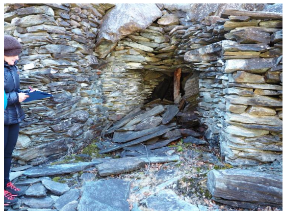
Molti degli accessi ai gioveli sono pericolanti e tutti necessitano di essere chiusi per evitare l'accesso al pubblico del Museo diffuso
