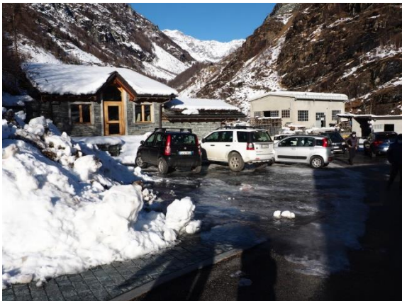
Il fabbricato del Consorzio Artigiani Cavatori della Valmalenco è dotato di ampio parcheggio sul lato est
