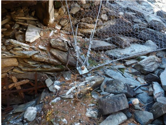
Le reti di protezione lungo il tratto di Sentiero Rusca che conduce all'area del Giovello assicurano adeguata protezione
